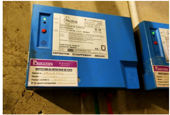
Détecteur de suites des cuves de fioul enterrées
