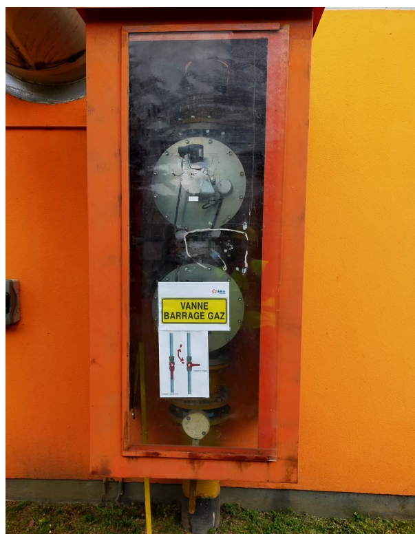
Vanne barrage du gaz utilisé pour alimenter les chaudières
